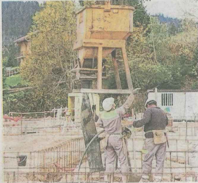
■ Les fondations du centre des mondes polaires sont terminées.
